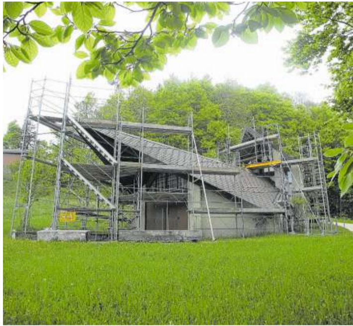
Die Bergkapelle Weissenstein ist schon eingerüstet.
